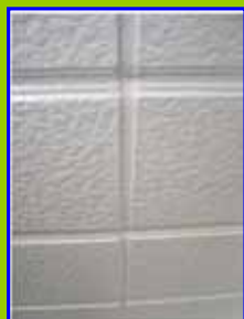
コーキング注入、塗装完了状態
